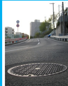
マンホールふた
